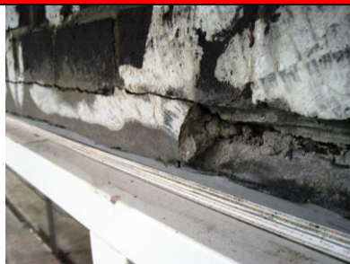
Ondergrond niet stabiel, schoon, vlak- en vetvrij.
