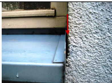
Metselwerkkopschot zonder dakje. Inwatering mogelijk.
