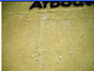
Blaasvorming sierpleister door inwatering bij de belettering.
