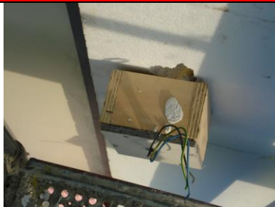
Klos wordt achteraf aangebracht. Deze vooraf monteren om de isolatieplaten goed te kunnen aansluiten.
