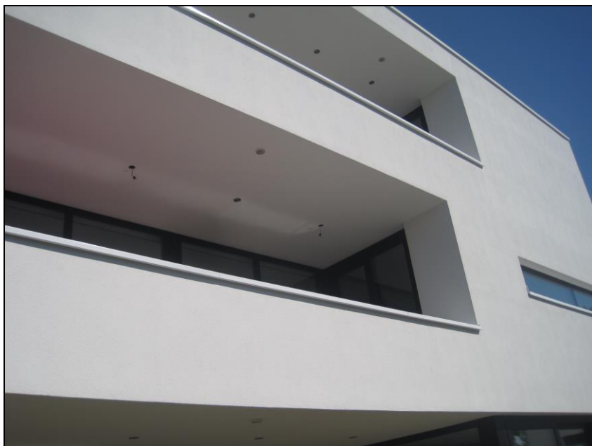
Woonhuis Goes. Muurafdekkers balkon met ingewerkte eindschotten.
