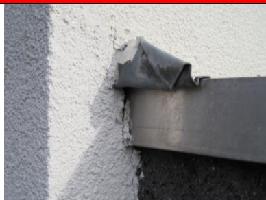
Technisch acceptabel maar minder duurzaam dan bij aansluiting met een daktrimbakje.
