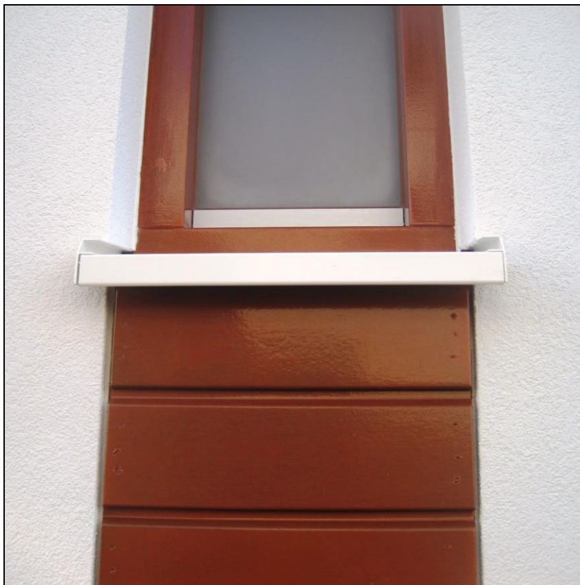
Gevelfragment woonhuis te Uden. Waterslag met stucwerkkopschotten (type dakje).
