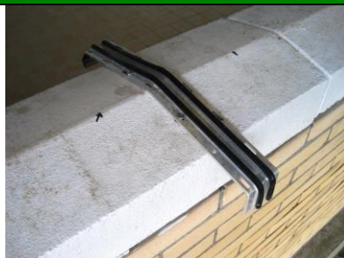
Waterdichte koppelstrip (met rubbers) van een nog aan te brengen muurafdekker.
