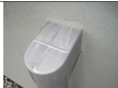
HWA-Afvoer waterdicht in de gevel aangebracht middels extra kitdichting.
