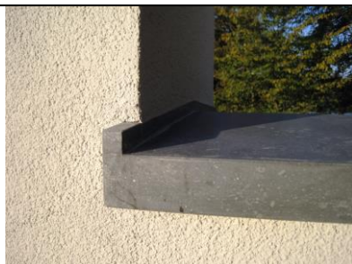
Hardstenen muurafdekker met neut (opstaande kant).
