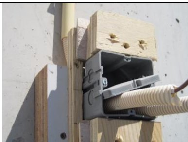
Maatvoering Klos erg klein (met maatvariaties). Tevens gekozen materialen niet correct.
