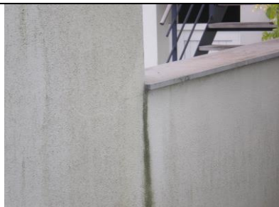
Vervuilde lekstroken door ontbreken van eindkap.
