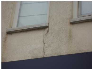
Vervuiling (lekstrepen) door ontbreken van neuten.
