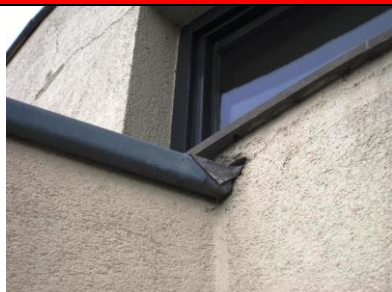
Daktrim koud aangebracht in en tegen naastgelegen gevel.
