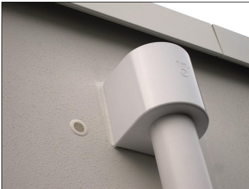
Gevelfragment villa Almere (dakrand, ventilatierooster en HWA).
