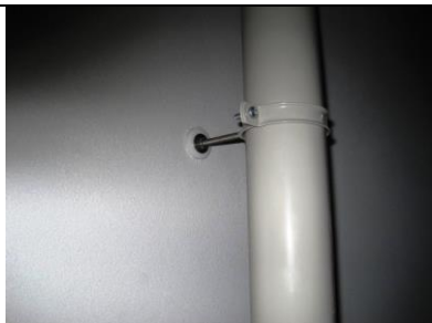
HWA pennen waterdicht in de gevel gemonteerd met afsluiting in de kit.
