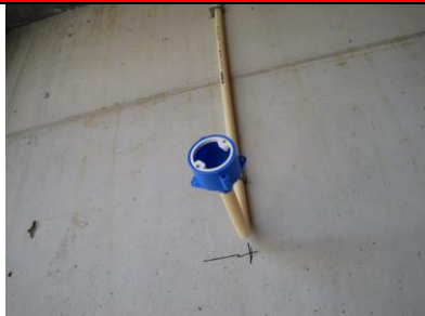
Nog geen Klos aangebracht.
