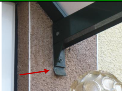
Voorkoming lekstrepen bij luifel door toepassing afdruiplaatje.
