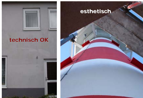
Afbeelding 5: Door verschil in dikte, structuur en kleur zijn reparatieplekken herkenbaar. De acceptatie daarvan is in elk project anders, en kan mede aanleiding zijn om nadien te schilderen.
