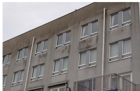
Afbeelding 2: Deze gevel uitgevoerd in krabpleister wordt met name vervuild tengevolge van de detaillering van de afdeksteen aan de bovenzijde. Reinigen van de gevel is alleen effectief als ook dit detail wordt verbeterd.
