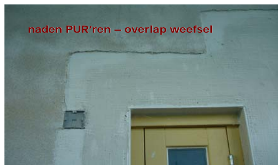
Afbeelding 4: Bij het uitvoeren van reparaties moet het functioneren van de mortelweefsellaag gewaarborgd blijven. Homogene dikte en overlap van afzonderlijke weefselstroken zijn daarbij cruciaal.
