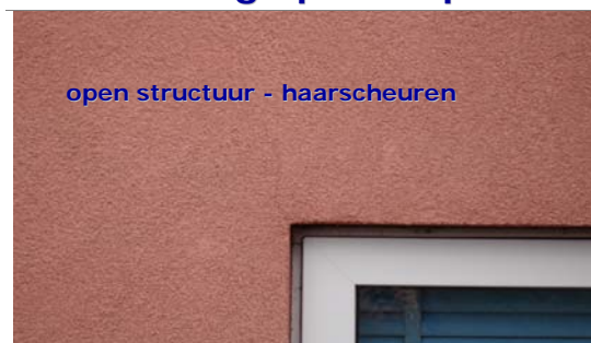
Afbeelding 1: Door veroudering krijgt spachtelpleister (kunstharsgebonden) een meer open structuur en verliest ook enige samenhang. Door deze degradatie kunnen op hoekpunten van raamkozijnen bijvoorbeeld haarscheuren ontstaan.
