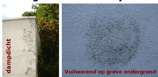
Afbeelding 8: Dampdichte verf kan afschilferen/loslaten van verf- of pleisterlaag tot gevolg hebben ( links ). In pleisters met een grove structuur blijft vuil makkelijk achter ( rechts ). Het nut van een vuilwerend (afparelend) verfsysteem komt niet tot zijn recht.
