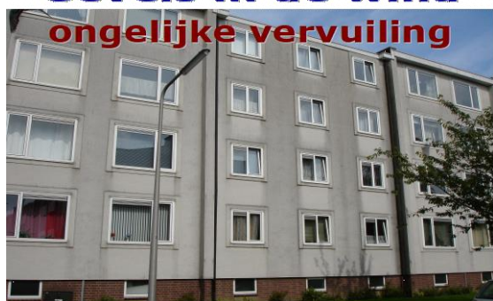
Afbeelding 5: Locatie en oriëntatie van de gevel zijn bepalend voor vervuiling. Ook bij een egale vergroaving van sierpleister, is deze op gevels in de wind ongelijkmatig verdeeld.
